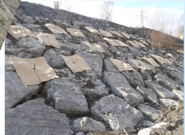
1 pieu pour 4m 2 (25 pieux par placette)
