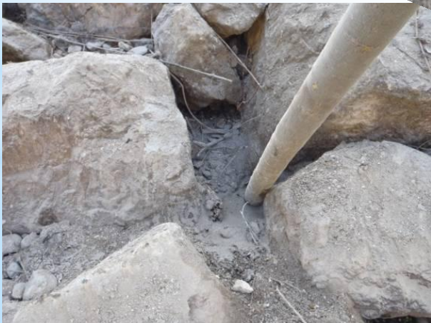
Pieu (3m mini - Ø 70mm) + remplissage (boue)
